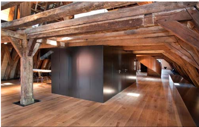
Bild 2-7 Das historische Gebälk wurde freigelegt und in den neuen Büro- und Seminarräumen als ursprüngliche Holzkonstruktion erlebbar gemacht (Foto: © Eifert Holzbau GmbH).
