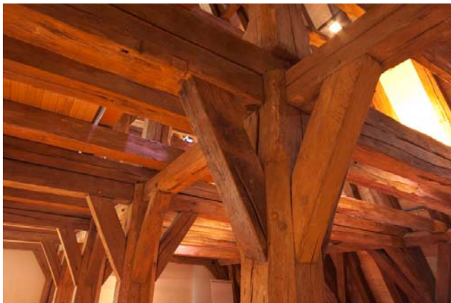
Bild 2-5 Das historische Gebälk wurde freigelegt (Foto: © Eifert Holzbau GmbH).
