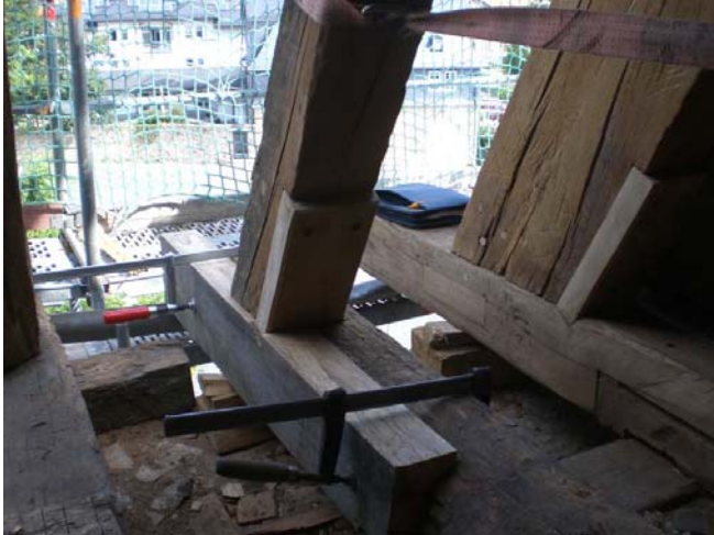
Bild 2-3 Die schadhaften Balken werden mit einem stehenden Blatt versehen und ein neuer Balkenkopf eingepasst. Die Verschraubung erfolgt mit Doppelgewindeschrauben (Foto: © Eifert Holzbau GmbH).
