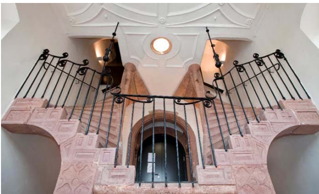
Bild 1-2 Der schlichte Renaissancebau verfügt über ein repräsentatives Treppenhaus (Foto: © konbau GmbH).
