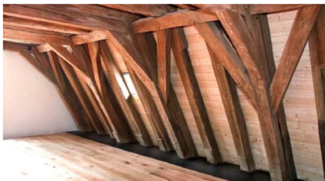
Bild 2-1 Das Solms-Hohensolmsmer Schloss verfügt über einen dreigeschossigen, gotischen Dachstuhl mit 200 Dachbalken (Foto: © Eifert Holzbau GmbH).
