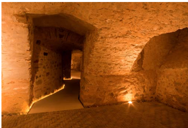
Bild 2-8 Die Kellergewölbe wurden von neuzeitlichen Einbauten befreit und werden zu Ausstellungszwecken genutzt (Foto: © Eifert Holzbau GmbH).
