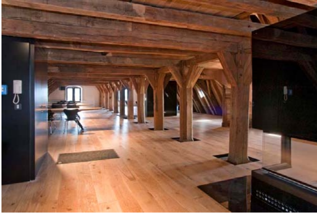
Bild 2-6 Das historische Gebälk wurde freigelegt und in den neuen Büro- und Seminarräumen als ursprüngliche Holzkonstruktion erlebbar gemacht (Foto: © Eifert Holzbau GmbH).
