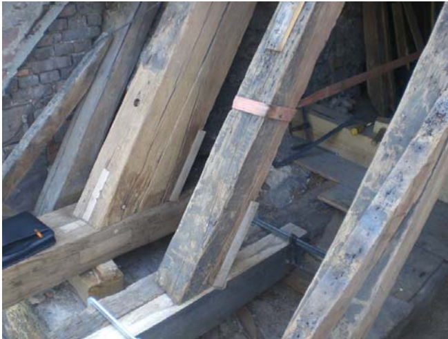
Bild 2-4 Verstärkung der Sparrenfußpunkte mittels Knaggen (Foto: © Eifert Holzbau GmbH).
