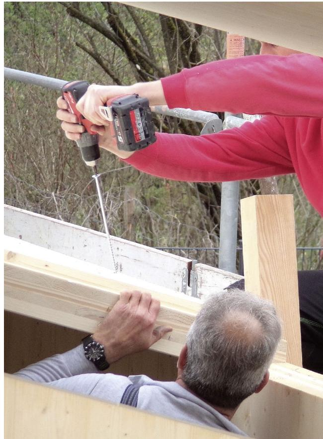
Auch die Dachelemente sind aus Brettsperrholz und insgesamt rasch montiert und befestigt.
