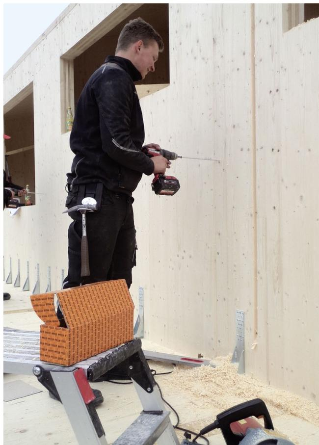
Die Tellerkopfschraube in der Abmessung 8,0 × 220 mm schafft bei der Befestigung der Wandelemente eine sichere Verbindung.
