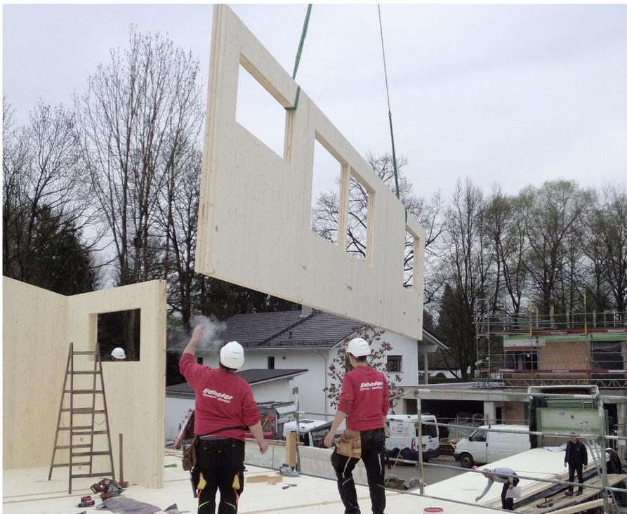
Schneller Holzbau: Innerhalb von drei Tagen stand der Rohbau des Brettsperrholzhauses.
